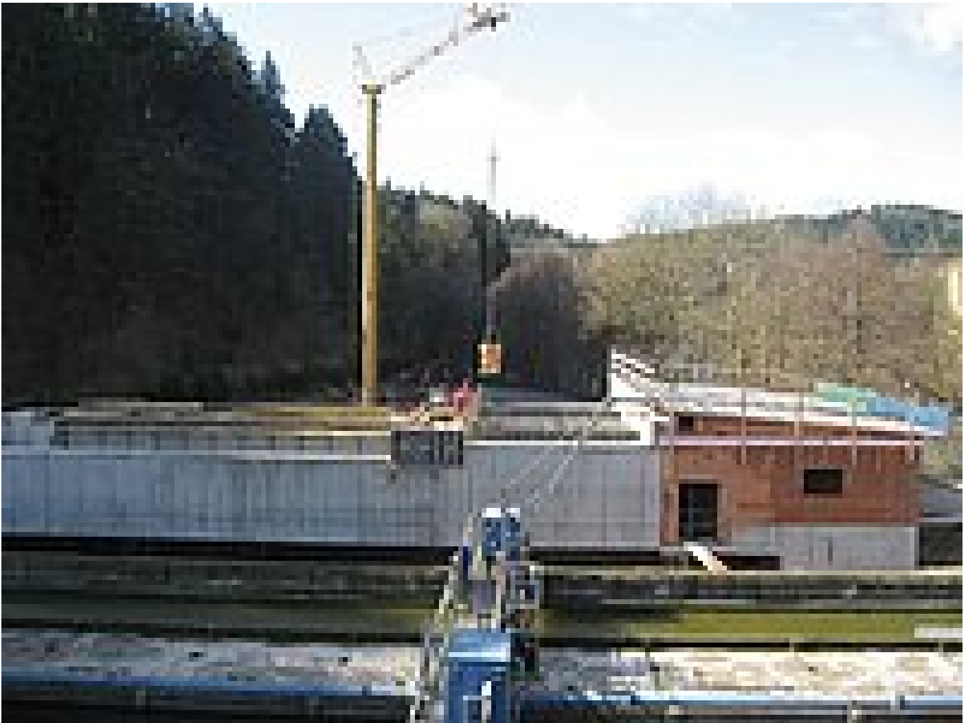
Baustelle Membrananlage Hutthurm im März 2008
