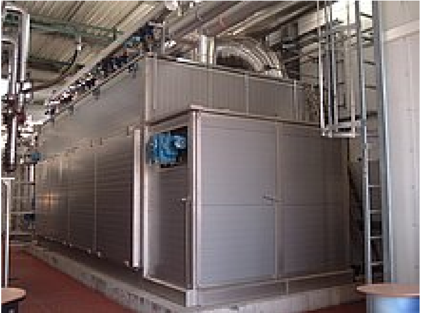
Mitteltemperatur-Trocknung von Klärschlamm mit HUBER Bandrockner BT
