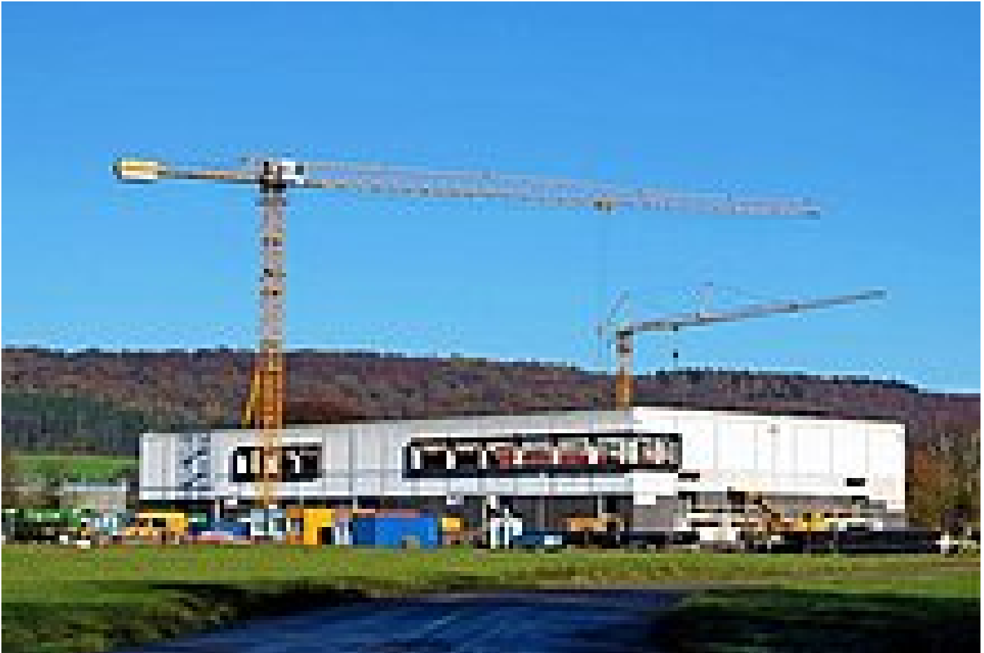
Bild 1: Die Großbaustelle des neuen Aufbereitungsgebäudes in Echthausen
