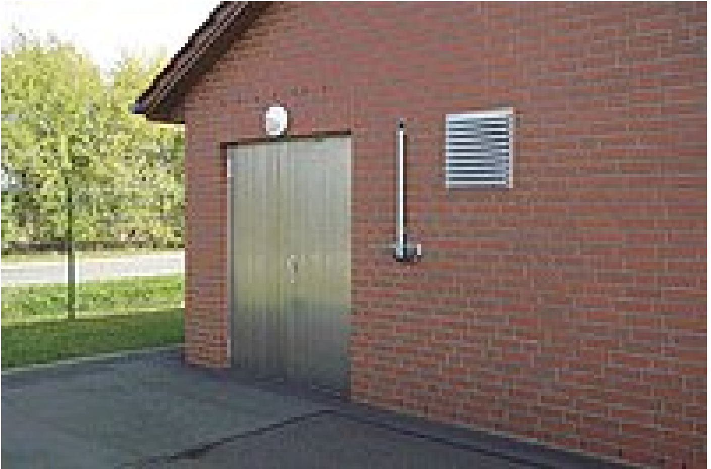
HUBER Sicherheitstür WK 3 als Zugang in das Rechengebäude
