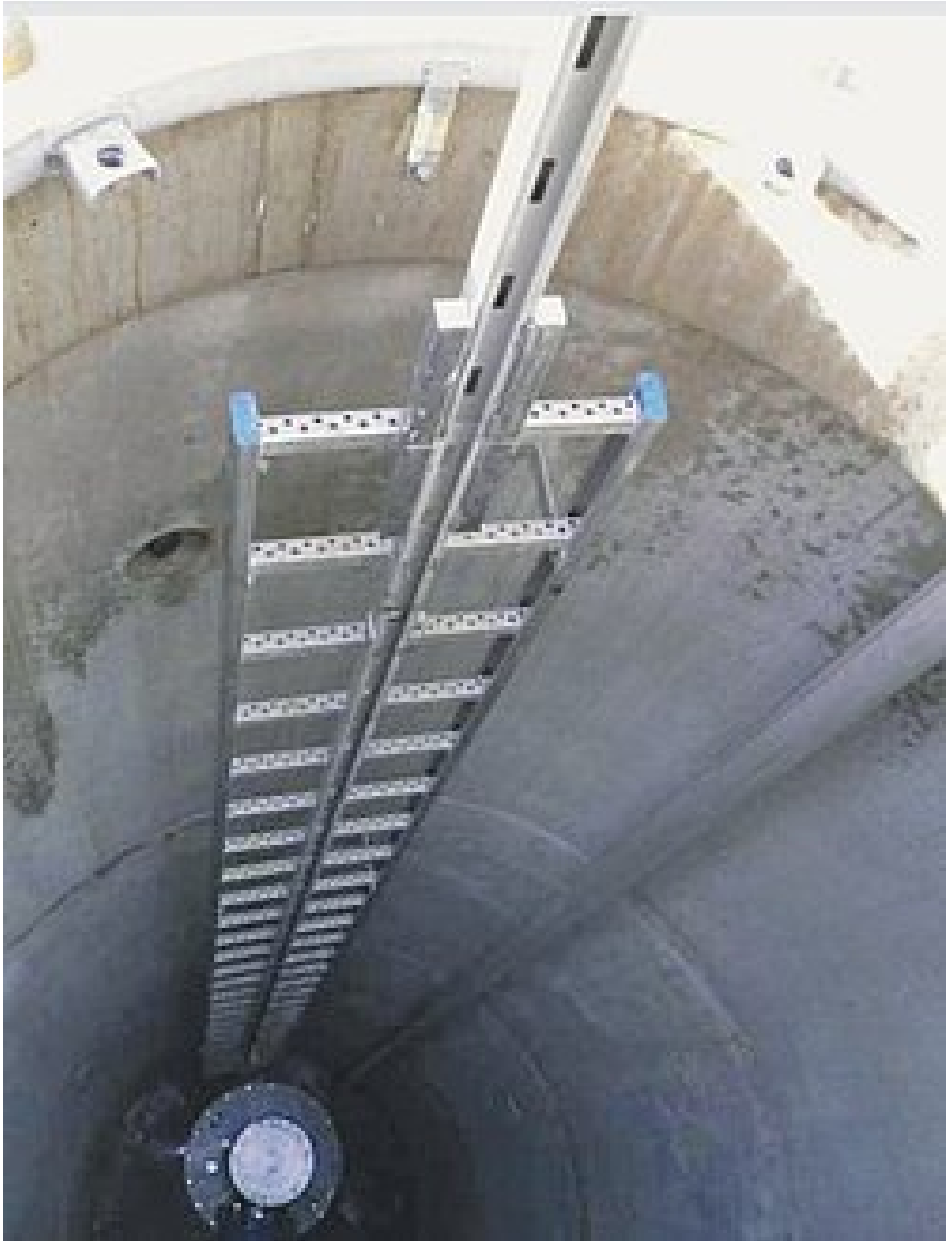
Sicheres Begehen: Leiter mit Sicherheitsfallschutzschiene
