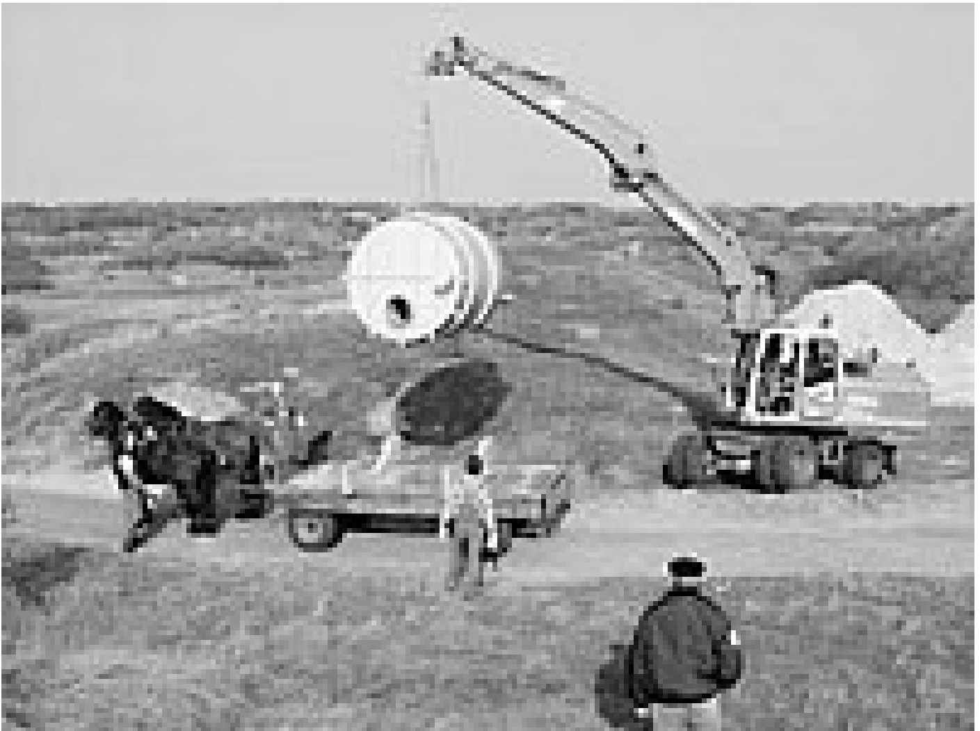
Abladen des Pferdefuhrwerkes am Montagestandort des Fertigschachtes
