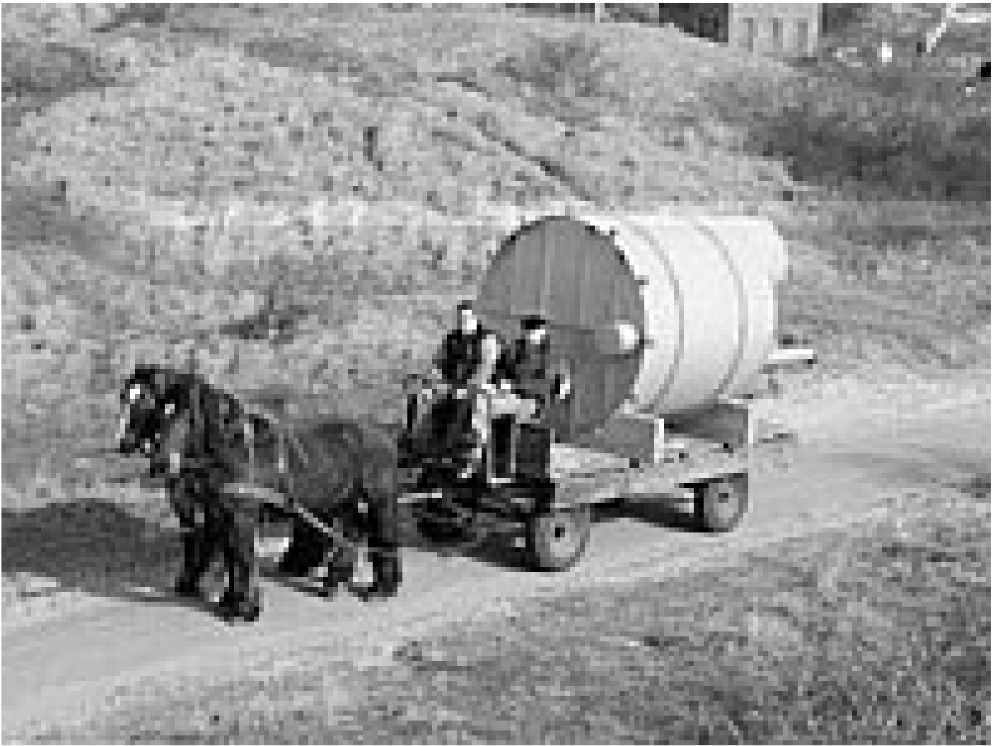
Transport des HUBER Fertigschacht mit dem Pferdefuhrwerk
