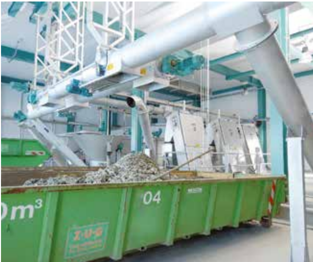
HUBER Rohrförderschnecke Ro8 V als Containerverteilerlösung.
