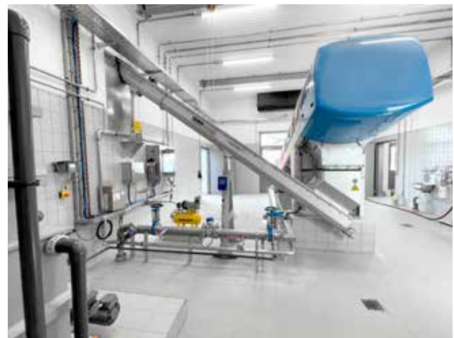
Schrägförderaufgabe nach einer HUBER Schneckenpresse Q-PRESS®.
