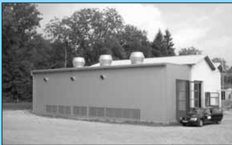
Trocknungsanlage der Harzwasserwerke
