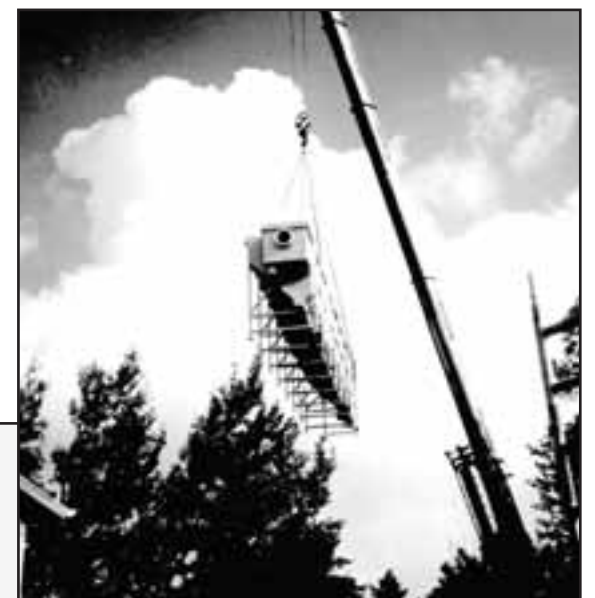
Bild 2, links: "Man gut, dass das Dach noch fehlt" KA Bargtheide:Montage 2 Stück Kompaktanlagen Ro5 80l/s oberirdisch
