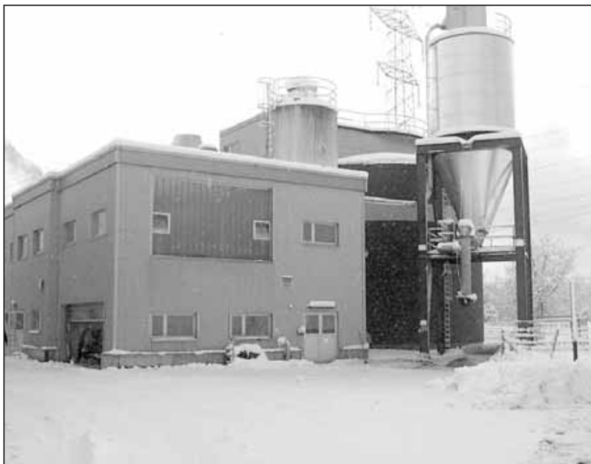
Betriebsgebäude „Trocknung“ der Kläranlage Schwyz
