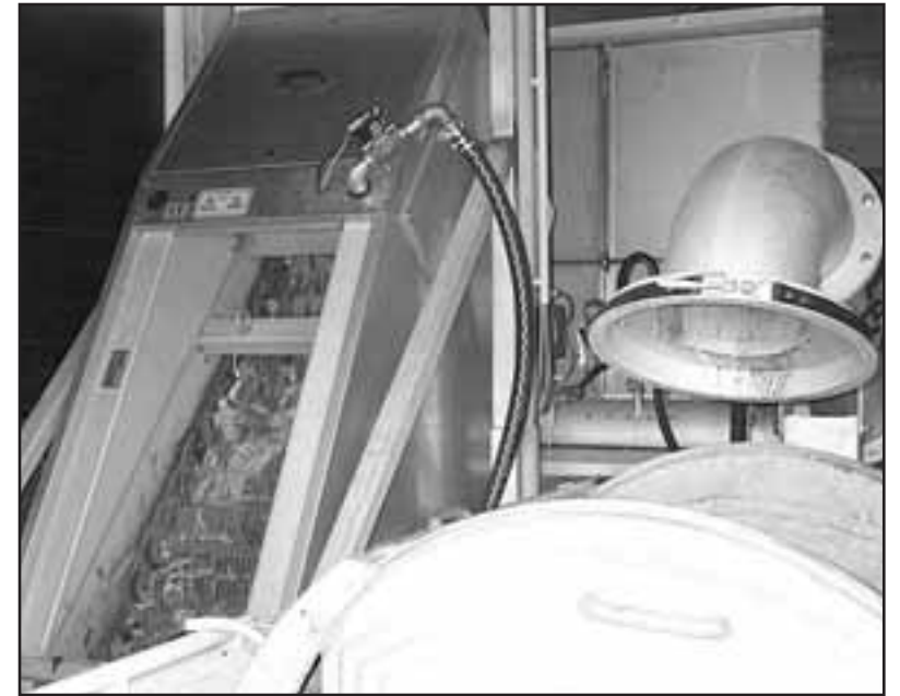
Die komplette mechanische Reinigung wurde von der Hans Huber AG montiert.
