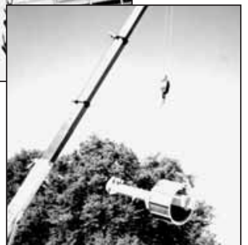
Bild 2, links: "Man gut, dass das Dach noch fehlt" KA Bargtheide:Montage 2 Stück Kompaktanlagen Ro5 80l/s oberirdisch
