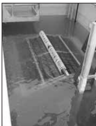
Bild 2: VRM ® -Unit im Belebungsbecken einer kommunalen Kläranlage
