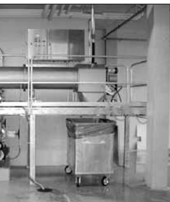
Abbildung 1: Typische Aufstellung eines Grobstoffdurchlaufabscheider STRAINPRESS®
