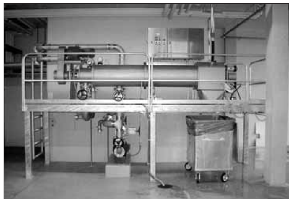
Abbildung 1: Typische Aufstellung eines Grobstoffdurchlaufabscheider STRAINPRESS®
