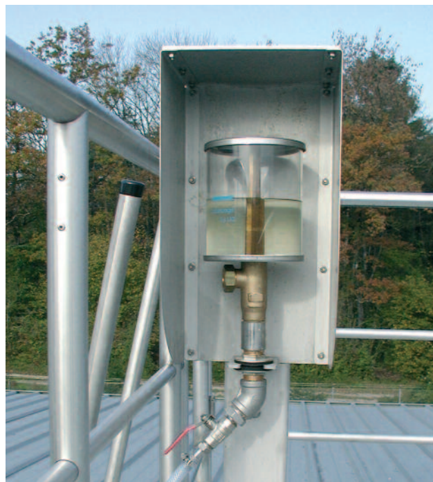
Leckageüberwachung für das Lager der VRM ®
