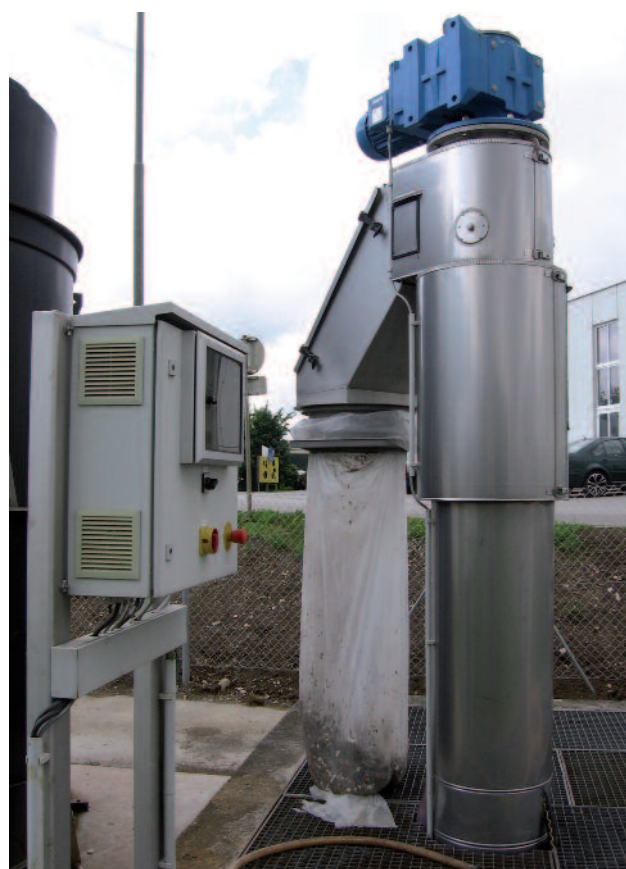
HUBER ROTAMAT® Schachtsiebanlage RoK 4-700-3, isoliert
