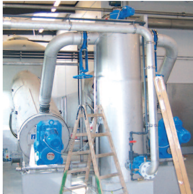
Flotatschlammmentwässerung mit zwei ROTAMAT® RoS 3/3 Schneckenpressen mit Flockungsrohrreaktor (während der Installation)
