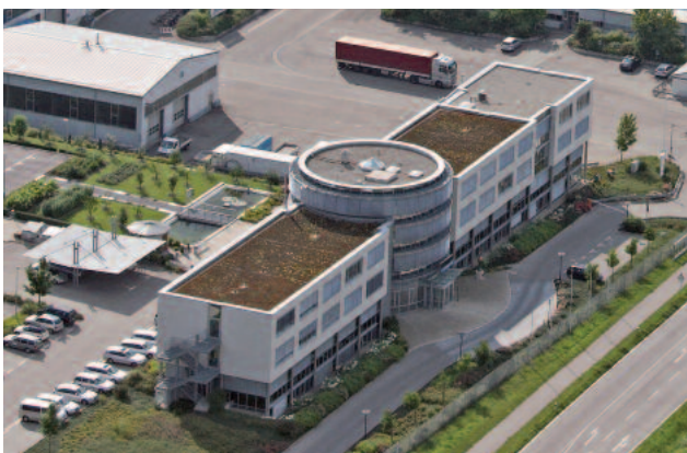
Bürogebäude der HUBER SE in Berching
