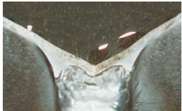
Feststoffe im Klarwasserablauf durch nicht optimierte Beckendurchströmung
