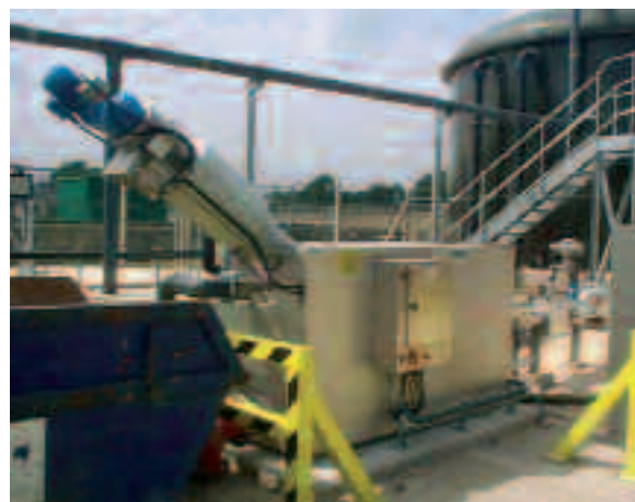
ROTAMAT® Schlamm-siebung – Schlamm-siebung in Freiluftaufstellung
