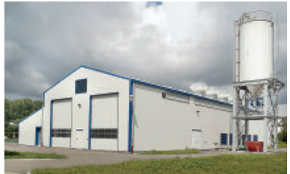
Schlüsselfertige HUBER Trocknung mit zwei Straßen und einem Trockengutsilo
