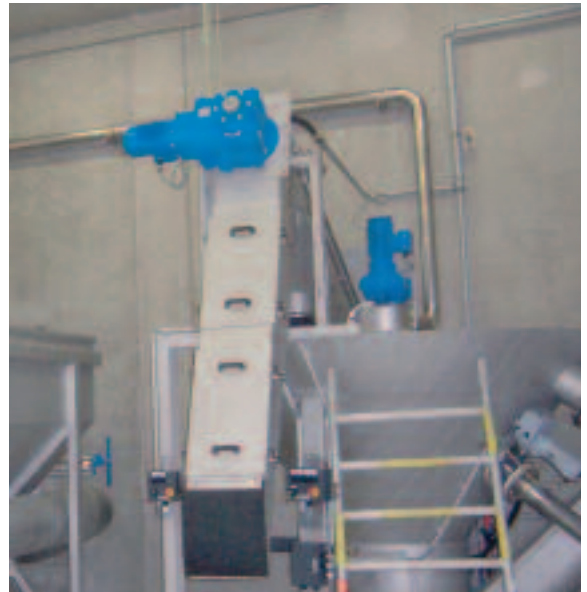
Anwendungsbeispiel: Rostseparator über der COANDA Sandwaschanlage
