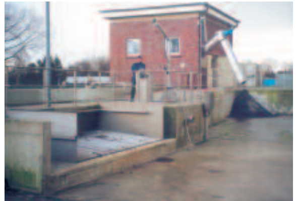
Kein Problem sind große Distanzen zwischen Bunker und Sandwaschanlage
