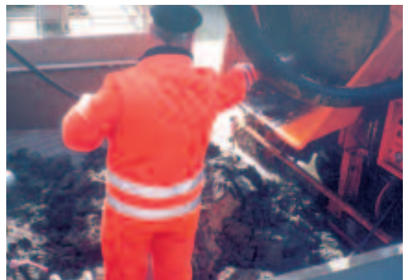
Tankfahrzeugentleerung auf dem Rüttelrost
