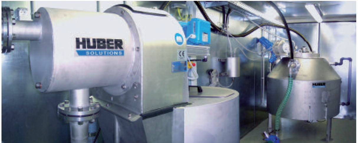
Einsatz des Pipestrainers zur Braunwassersiebung zur späteren Gewinnung von Humus
