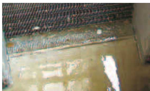
Ausführungsbeispiel mit Anbindung an das Gerinne für den sohlebener Abtransport der Abwasserinhaltsstoffe
