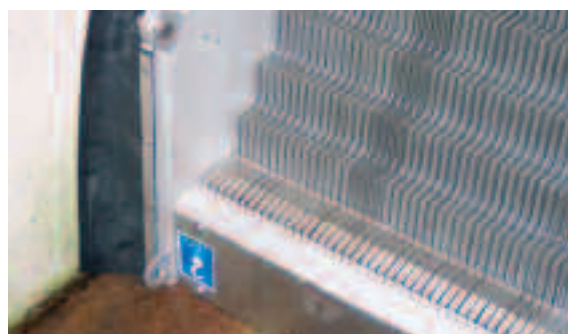
SSV – eingebaut in vorhandenes Gerinne
