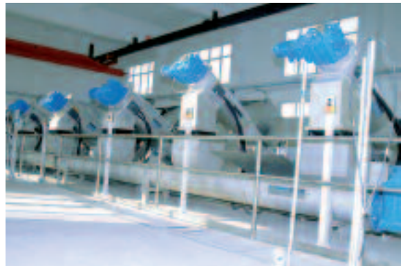
RoMem Feinstsiebungsanlagen: Siebung großer Abwassermengen im Zulauf von Membrankläranlagen
