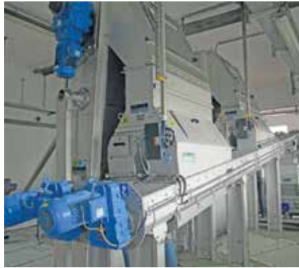
HUBER Transportschnecke Ro8 / Ro8 T, einsetzbar für alle Arten von Fördermedien und Einbausituationen.
