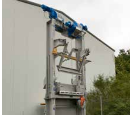
HUBER Schallengreiferrechen TrashLift für eine sichere Entnahme großer Störstoffe.
