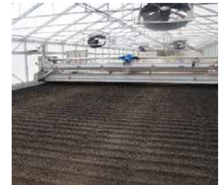
Entwässertes Klärschlamm wird zu einem trockenen, stabilen Schlammgranulat.
