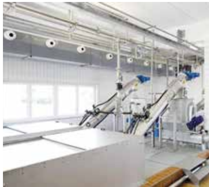
HUBER Siebanlage ROTAMAT® Ro2, Siebkorbdurchmesser bis 3 m möglich.
