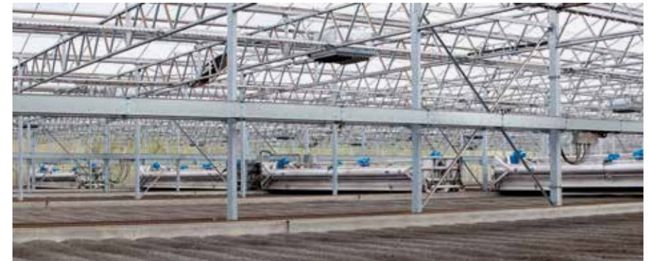
Parallelbetrieb HUBER Schlammwender SOLSTICE®.
