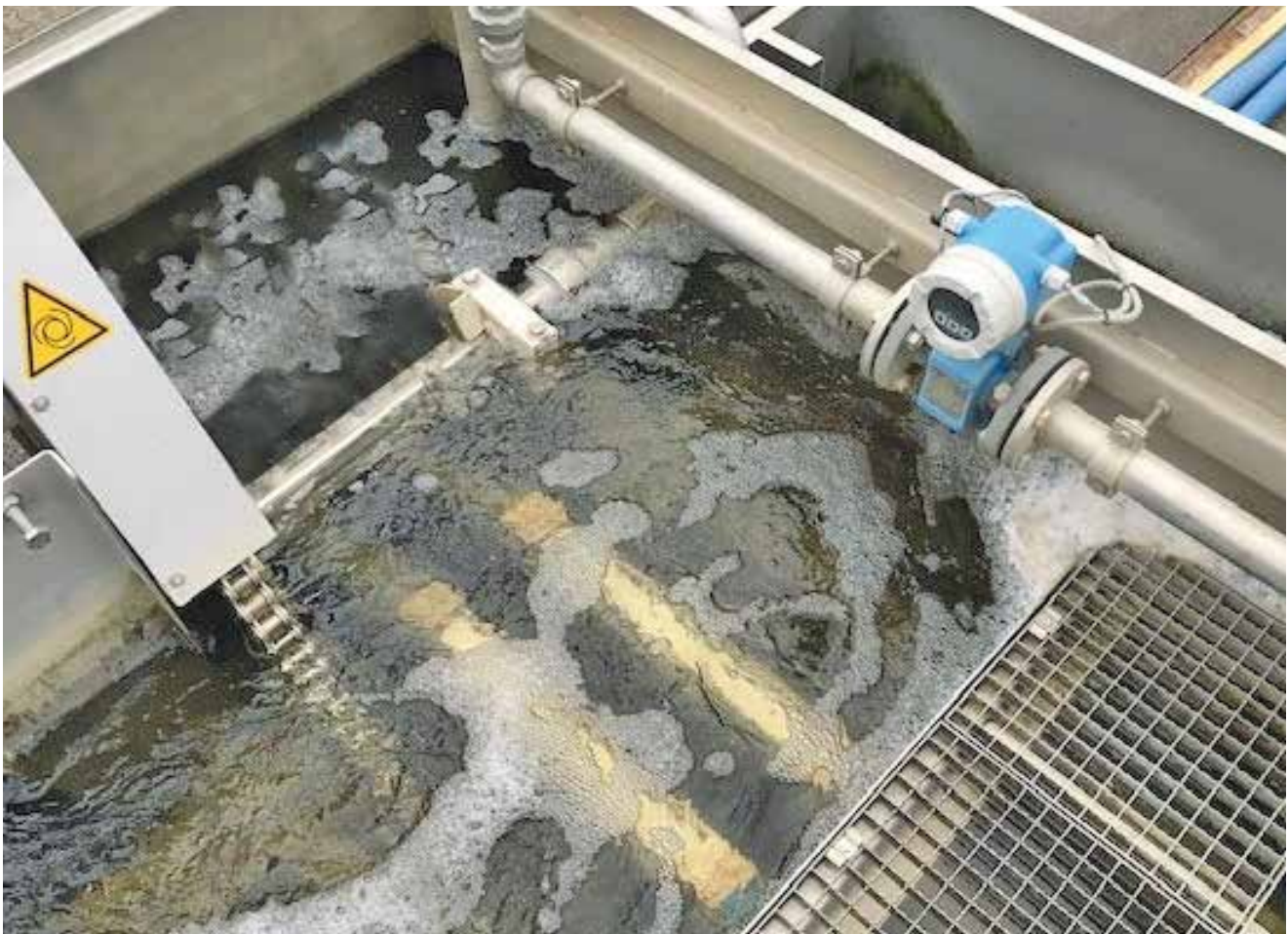
HUBER Tuchfilter RotaFilt® in Betrieb.
