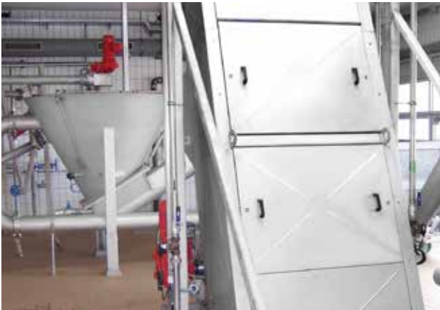
HUBER Stufenrechen STEP SCREEN® SSV im Gerinne ausschwenkbar ohne Demontage der nachgeschalteten HUBER Rechengutwaschpresse.
