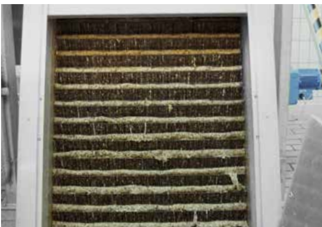
Mit dem HUBER Stufenrechen STEP SCREEN® SSV sind sehr große Abscheideleistungen durch feine Spaltweiten und sich bildenden Rechengutteppich realisierbar.
