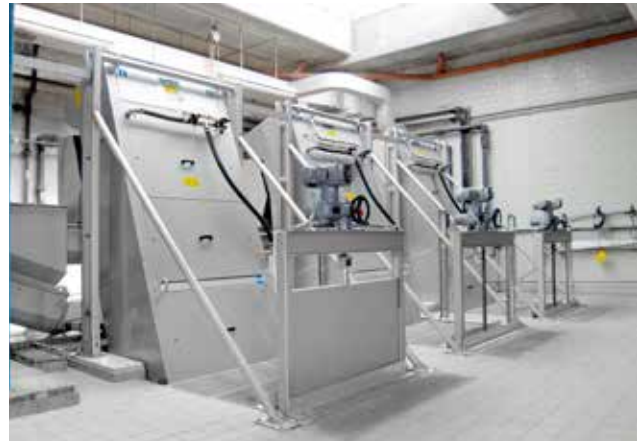
HUBER Stufenrechen STEP SCREEN® SSV: Länge 4300 mm, Spaltweite 3 mm, aus Edelstahl gefertigt und im Vollbad gebeizt für einen optimalen Korrosionsschutz.
