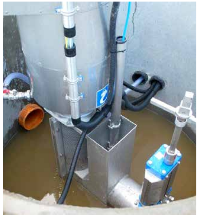
Blick auf den durchströmten Siebkorb.
