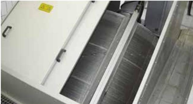
Gerinneeinbau der HUBER Siebanlage ROTAMAT® mit verschiebbarer Edelstahlabdeckung – Baugröße 600 bis Baugröße 3000.
