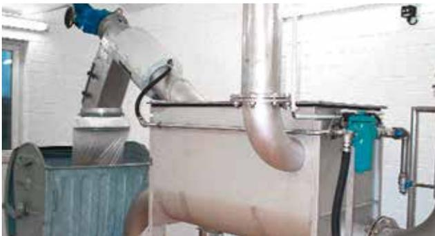
Behälterausführung der HUBER Siebanlage ROTAMAT®...
