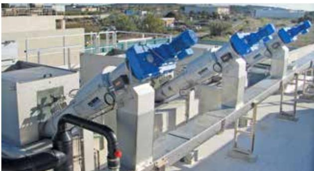
3 x ROTAMAT® STAR Baugröße 1000 mit 1,5 mm Lochweite zum Schutz einer Membranbelebungsanlage.
