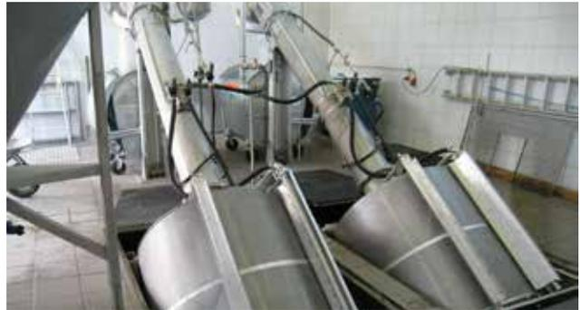
Geringer Platzbedarf durch den Einsatz von zwei HUBER Siebanlagen ROTAMAT® RPPS im Gerinne – Baugröße 1400.
