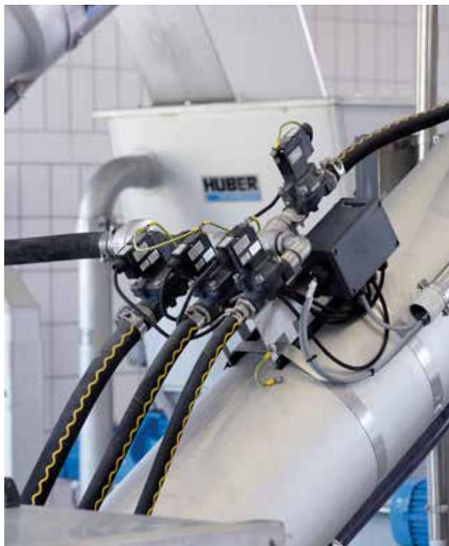
HUBER Siebanlage ROTAMAT® mit integrierter Rechengutauswaschung IRGA.
